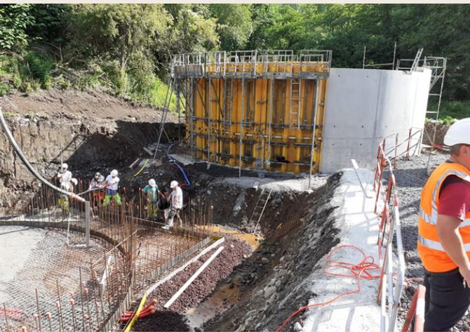
La nouvelle station d'épuration se monte peu à peu à coté de l'ancienne toujours en fonctionnement. 6000 m<sup>3</sup> de béton seront nécessaires à sa construction.
